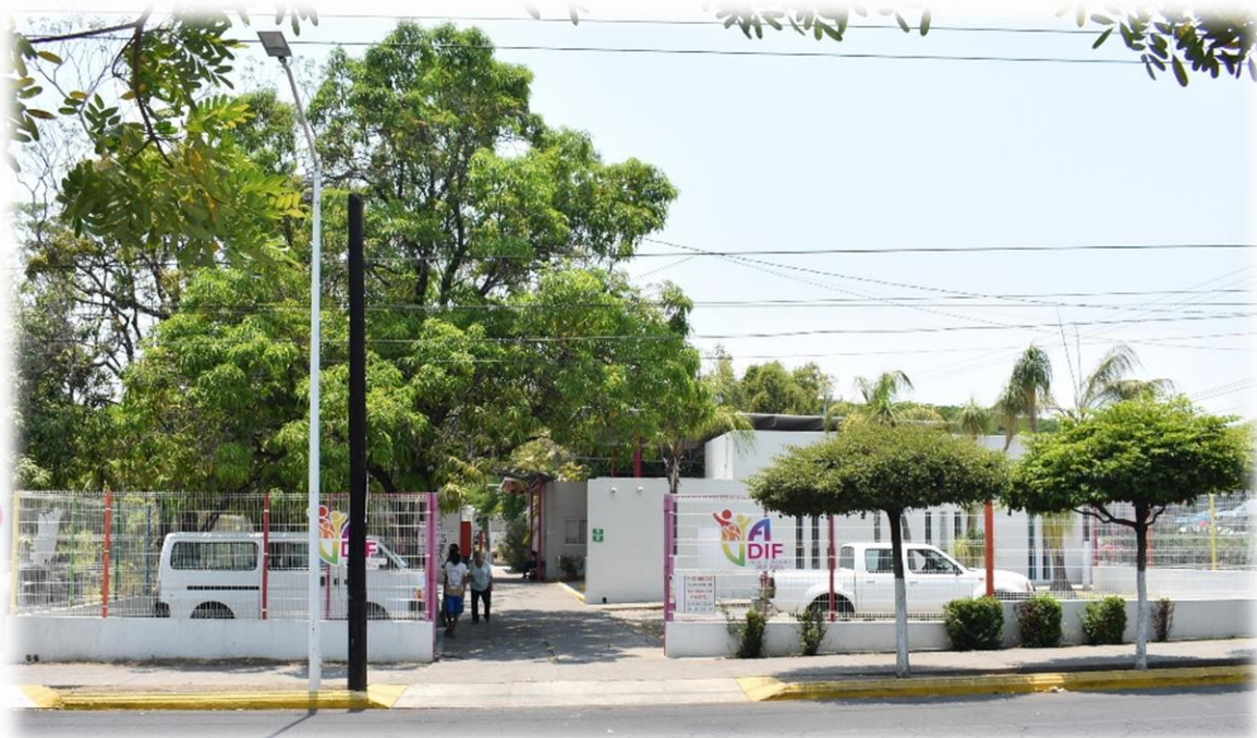
Fachada actual del edificio DIF Mayo 2025
